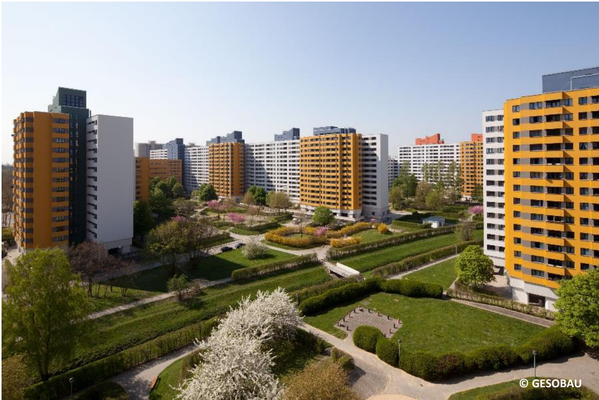
Abbildungen 20 a und b: Die sanierten Wohnhochhäuser von Werner Düttmann mit ihren großen, grünen Innenhöfen
