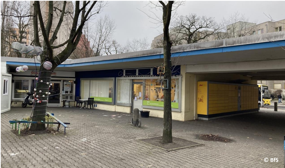
Abbildung 27: Sanierungsstau bei öffentlichen Freiflächen im PLR Rollberge
